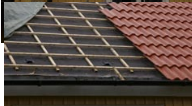
Den dåliga takpappen syntes tydligt när teglet tagits bort (stora bilden). Mögelstopparna i takets nederkant (lilla bilden) ska hindra framtida fuktangrepp. (Foto C-H Segerfeldt)
